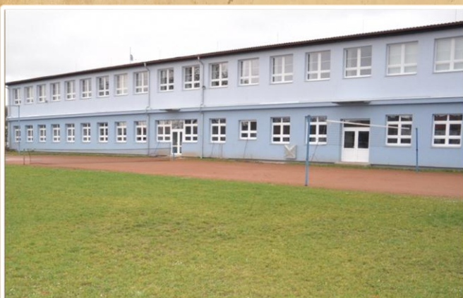
přístavba dílen po rekonstrukci
